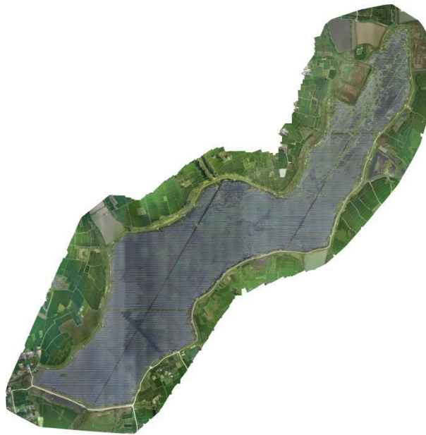
图 3-4 金阳光伏电站实景图
