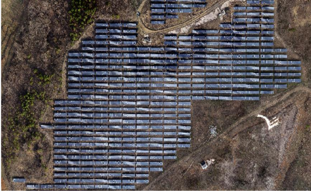
图 3-3 光伏电站实景图
