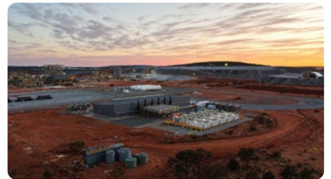
图38 澳大利亚最大矿山微电网项目
