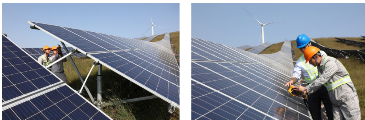
图2：光伏组串人工巡检
